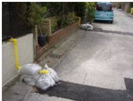
②外付けの配管で復旧した上水道
